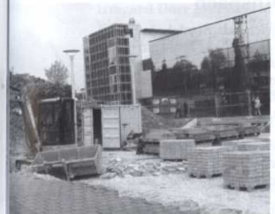
Derzeit entsteht ein Erweiterungsbau für neue Klassenräume.
