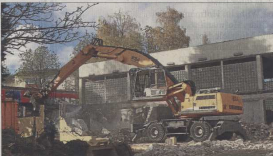
Die Sanitär- und Umkleieräume der alten Sporthalle an der ARS sind bereits abgerissen. Foto: Pieren
