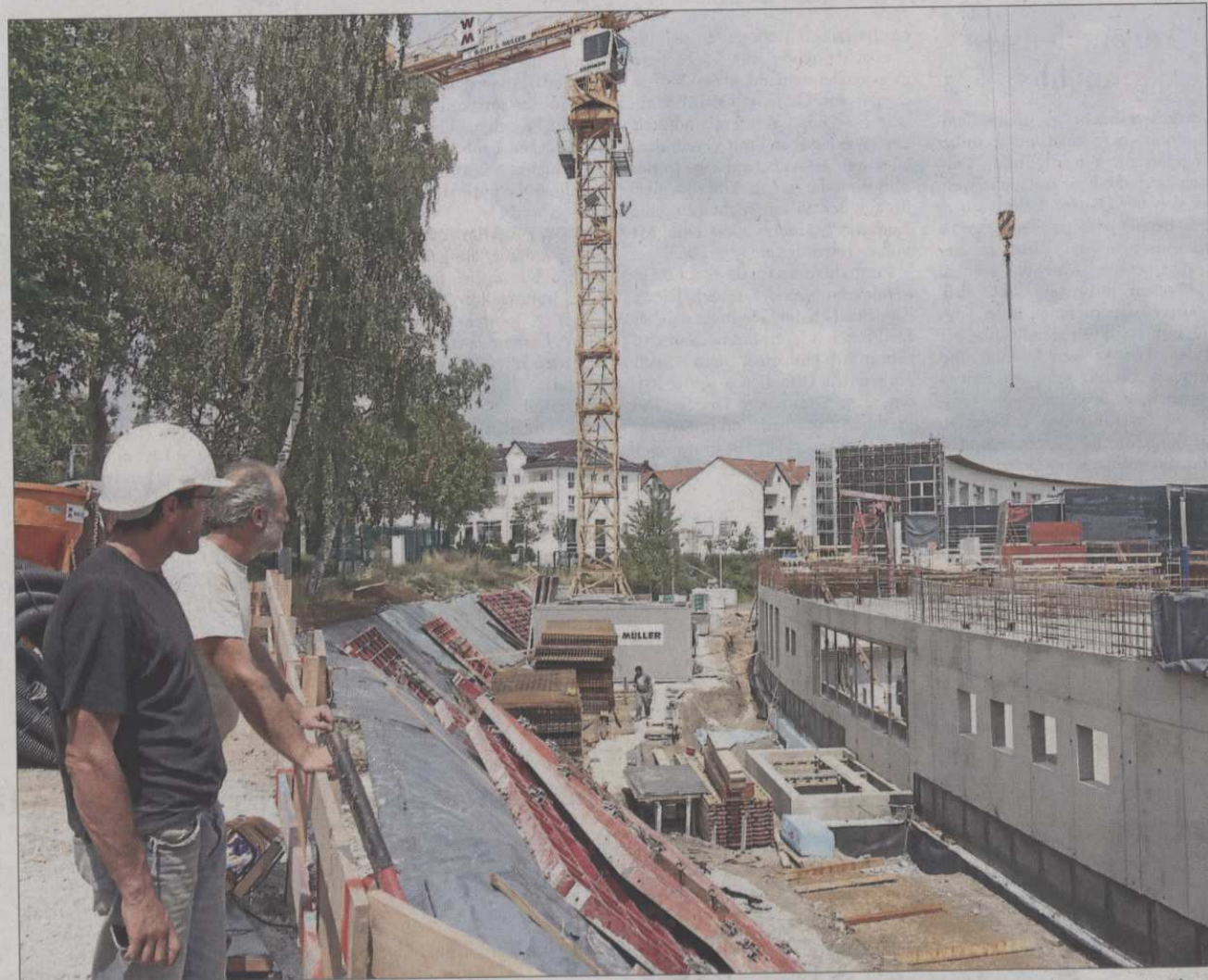
Zwei Bauarbeiter beobachten die Fortschritte am neuen Erweiterungsbau der Adolf-Reichwein-Schule.
