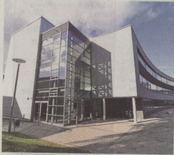
Erweiterungsbau der ARS: drei Geschosse, 2750 Quadratmeter, 30 Schulräume, 16 Monate Bauzeit und 9,5 Millionen Euro Baukosten.
