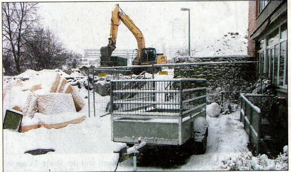
Zumindest der Bau für die neue Dreifeldsporthalle geht voran und soll im Frühjahr 2011 vollendet sein. Bild: Stehr
